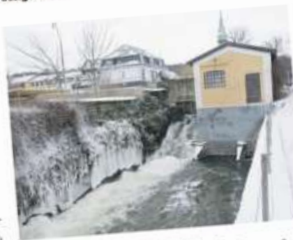
Set fra modsatte side tager turbinehuset sig noget bedre ud. Foto: Jan Stephan.
