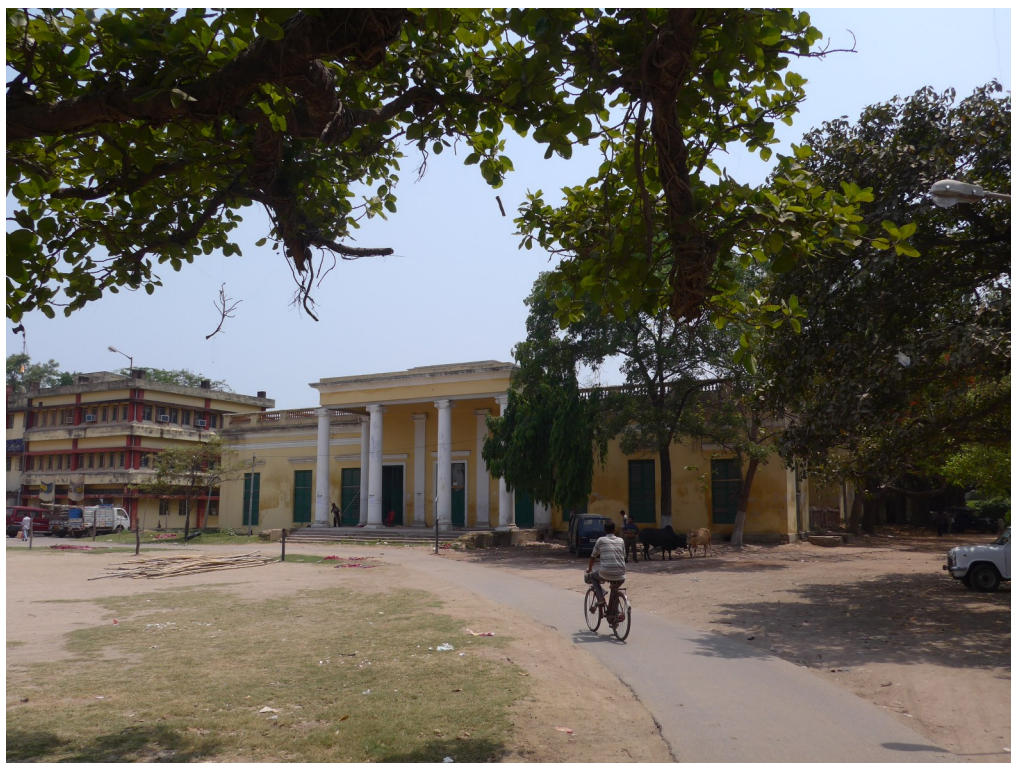
Guvernementshuset i Serampore, mens restaureringen var i fuld gang.
